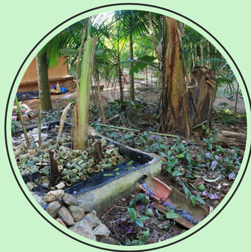
Zona de raízes para pia e ducha do banheiro de uma casa de terra. Local: Instituto TIBÁ, Bom Jardim-RJ.
