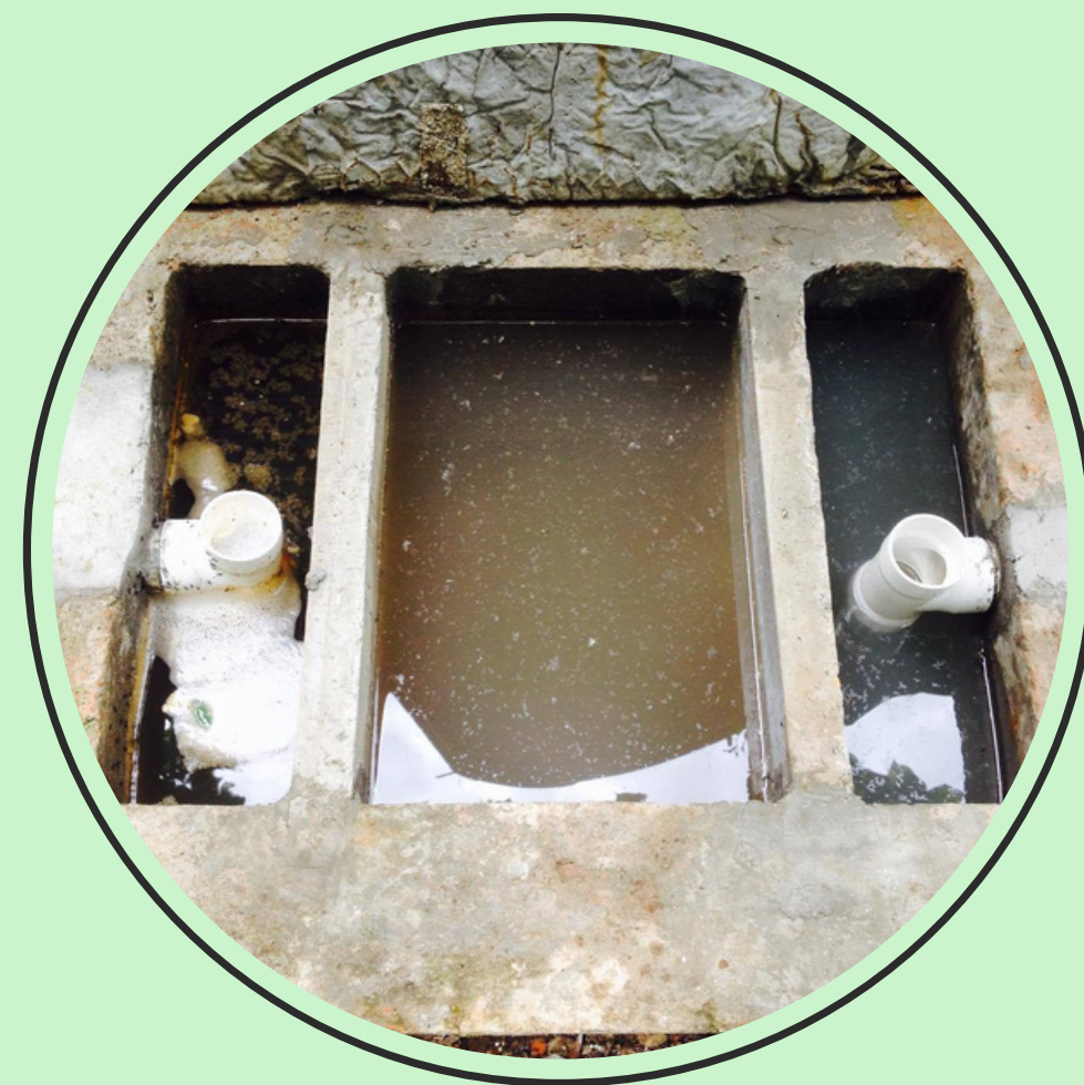
Dimensionamento de Caixa de Gordura para cozinha. Local: México.
