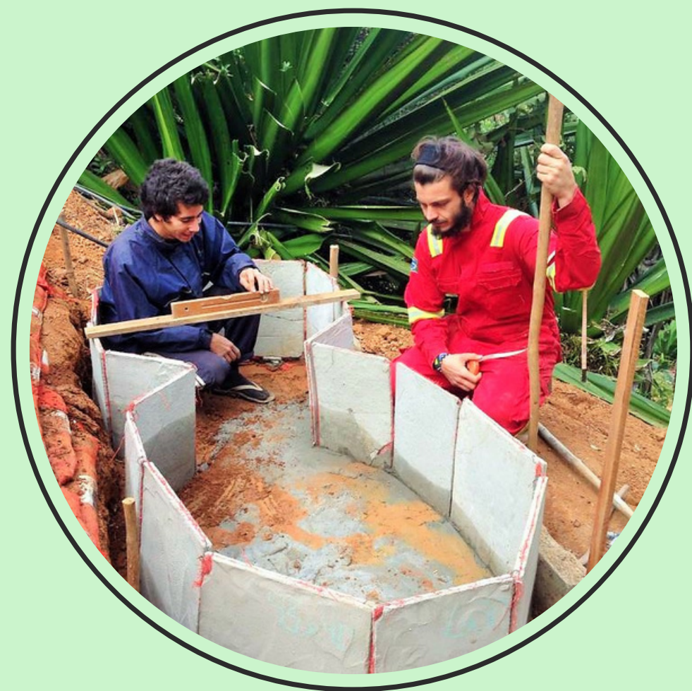
Zona de raízes para uma casa de terra, para quatro pessoas. Local: Instituto TIBA, Bom Jardim-RJ.
